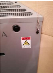
転倒防止ワイヤー取り付け例
