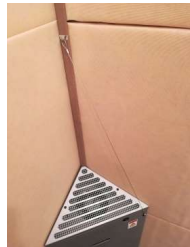
転倒防止ワイヤー取り付け例
