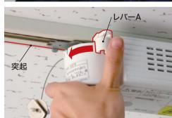
レバーA/Bのある側を、配線ダクトの突起がある側と反対に位置するように設置します。
